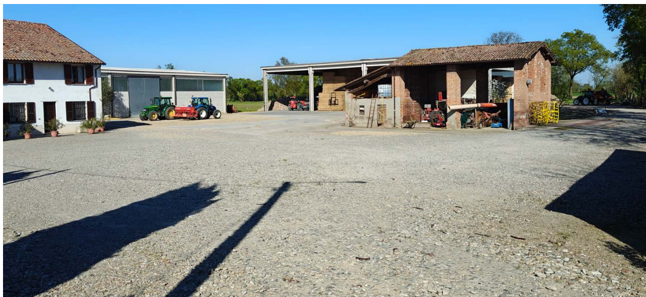
Figura 3.4 – Pavimentazione sabbiosa-ciottolosa di riporto nel piazzale principale di C.na Capsona.
