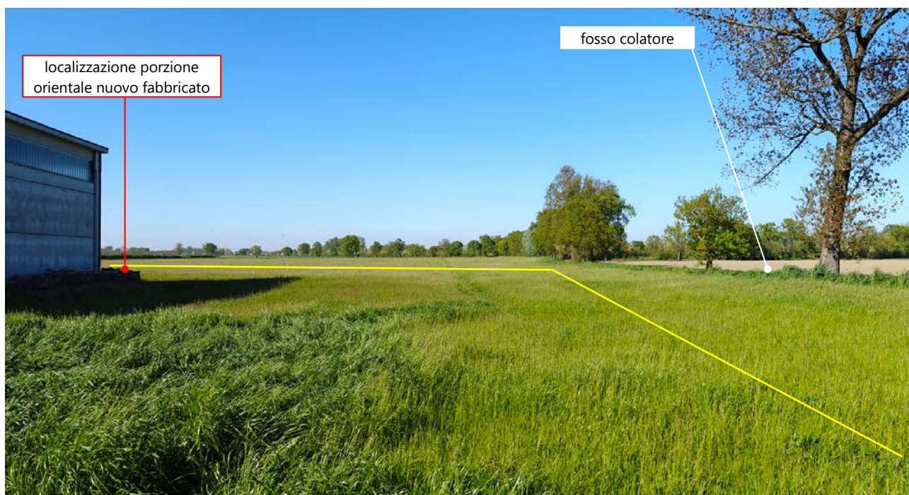
Figura 3.3 – Limiti indicativi dell'area oggetto di variante (linea gialla) tra i fabbricati esistenti il ramo est del fosso colatore presente a confine (vista rivolta verso nord).
